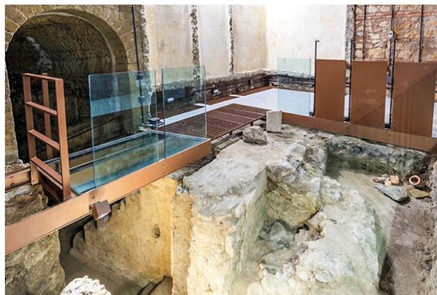
Fig. 17 - Passerella in acciaio e vetro sospesa sull'area archeologica e le scale di accesso all'antica cisterna poi mitreo; stato post operam (Foto di C. Poggi)
