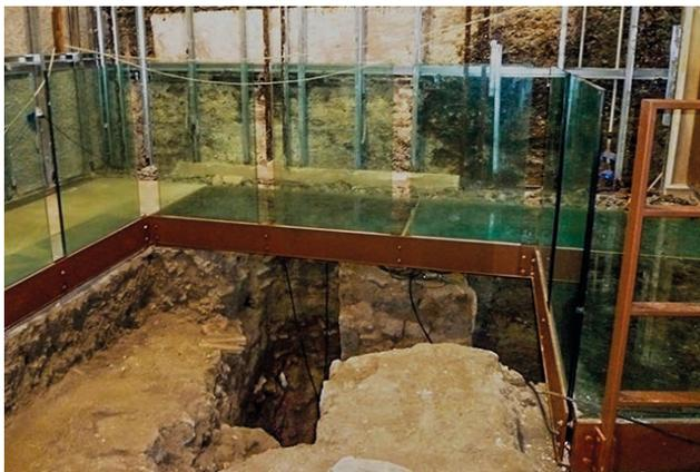
Fig. 8 - Struttura in acciaio e vetro sovrastante l'area archeologica presente nell'anticamera del mitreo; stato ante operam (Foto di C. Carocci)
