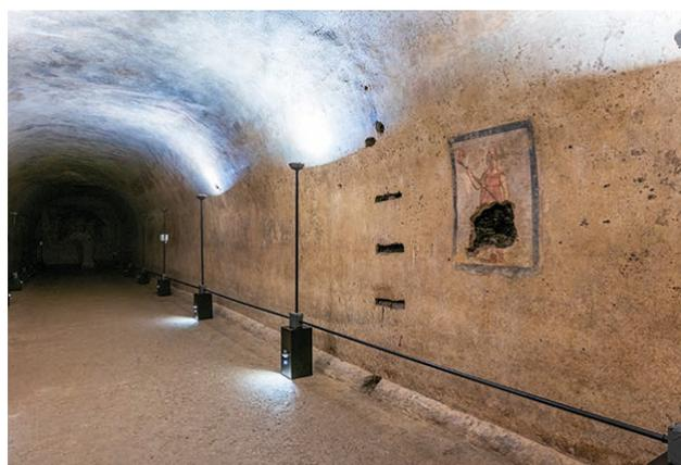
Fig. 27 - Sistema di illuminazione originale costituito da lampade led poste in corrispondenza delle nicchie ospitanti le antiche lucerne; stato post operam (Foto di C. Poggi)
