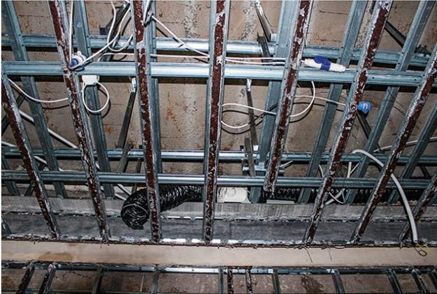
Fig. 12 - Impianti elettrico e di aspirazione nascosti nella struttura in alluminio del controsoffitto; stato ante operam (Foto di C. Carocci)
