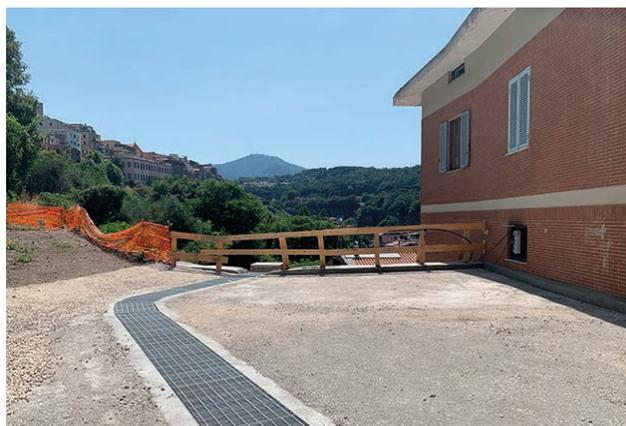
Fig. 21 - Canale di raccolta e deflusso delle acque meteoriche e dei pluviali degli edifici posto nell'area al di sopra del mitreo; stato post operam (Foto di E. Todini)
