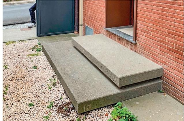
Fig. 13 - Ingresso all'anticamera del mitreo impraticabile da persone fragili o con disabilità motoria; stato ante operam (Foto di C. Carocci)
