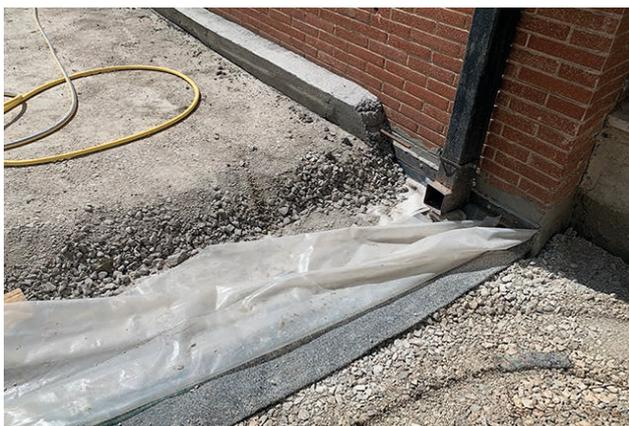
Fig. 20 - Stratigrafia del sistema di drenaggio delle acque meteoriche nell'area posta al di sopra del mitreo; stato post operam (Foto di E. Todini)
