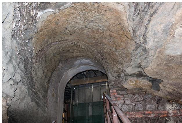
Fig. 11 - Volta della galleria del mitreo soggetta a infiltrazione delle acque piovane; stato ante operam (Foto di C. Carocci)
