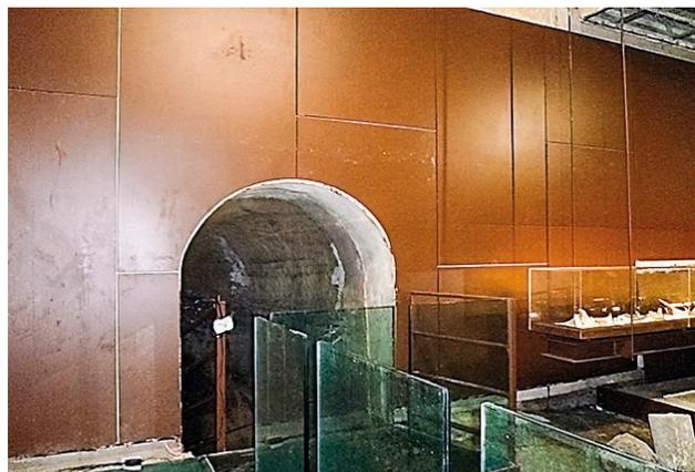
Fig. 7 - Rivestimento delle pareti dell'anticamera al mitreo, realizzato in lastre di acciaio corten, compromesso dall'umidità; stato ante operam (Foto di C. Carocci)
