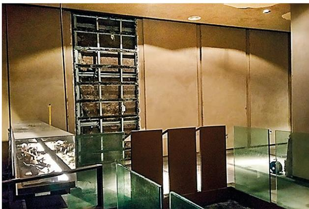
Fig. 6 - Rivestimento delle pareti dell'anticamera al mitreo, realizzato in pannelli, compromesso dall'umidità; stato ante operam (Foto di C. Carocci)
