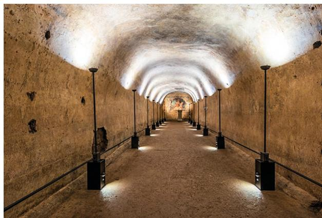
Fig. 19 - Impianto illuminotecnico caratterizzato dall'accensione progressiva delle lampade al passaggio del visitatore; stato post operam (Foto di C. Poggi)
