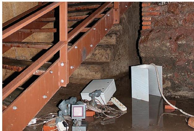
Fig. 5 - Presenza di acqua sotto la scala di accesso alla galleria del mitreo; stato ante operam (Foto di C. Carocci)
